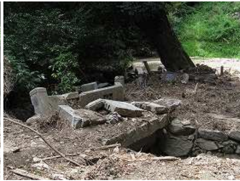
参道の橋が残っていた。
