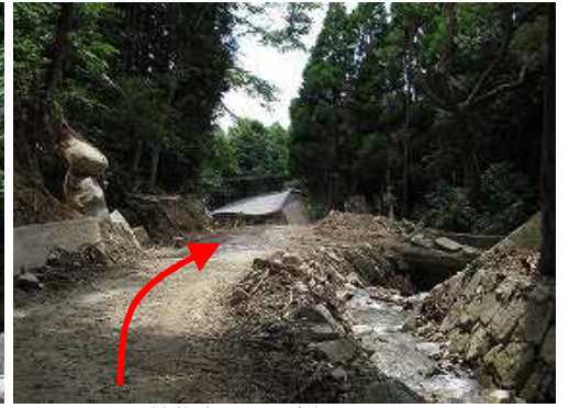
舗装路もろとも流されている。
