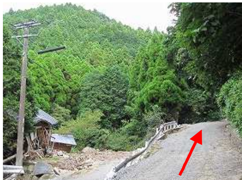
7/6～7/7の豪雨により路面が流された道路の路肩に駐車し上流へ向かう。
