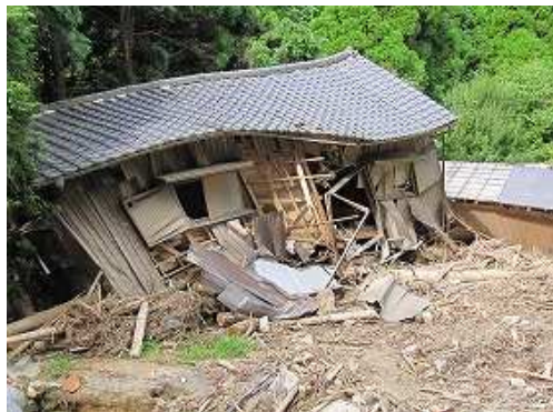
道路近くの建物は歪んでいる。
