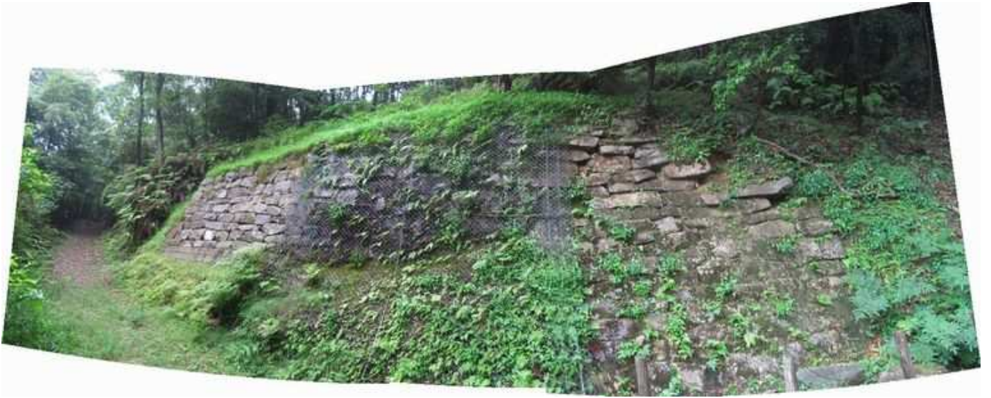
修復された石垣。
