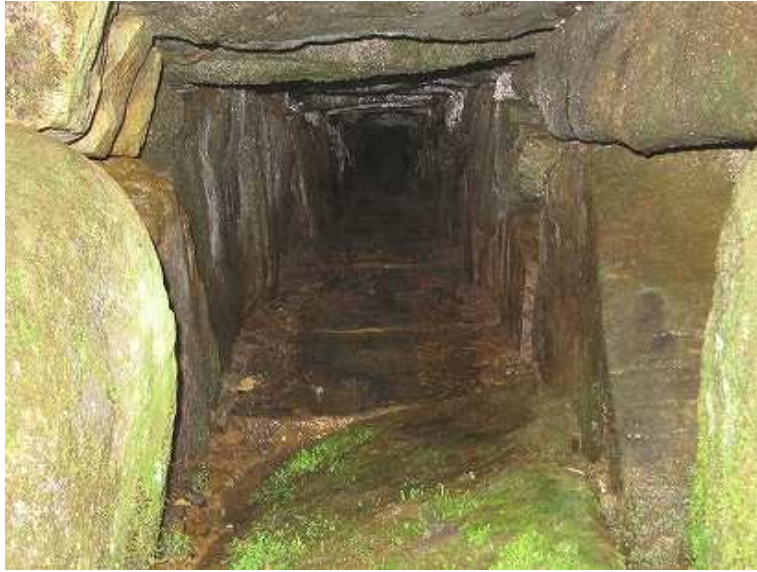
北水門の内部は、閉塞などなく良好な状態である。
