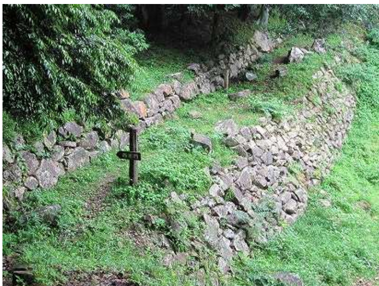
左側から見た水門で縦横の目地はズレており、基山の南水門と同じ積み方である。
