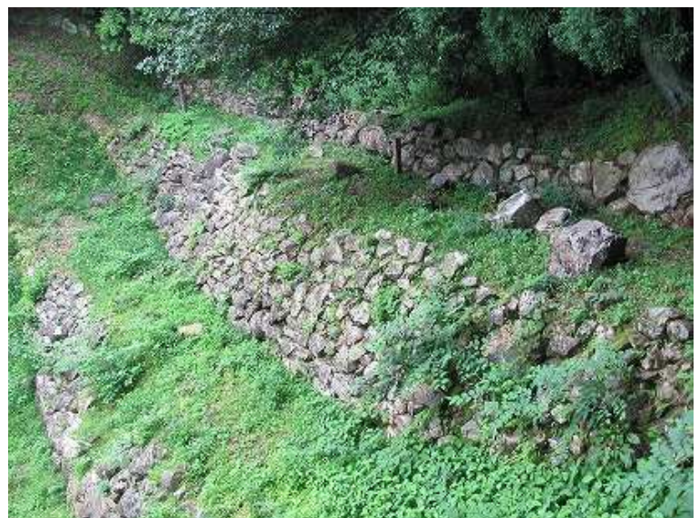
右側から見た西水門。水門は見当たらなかった。
