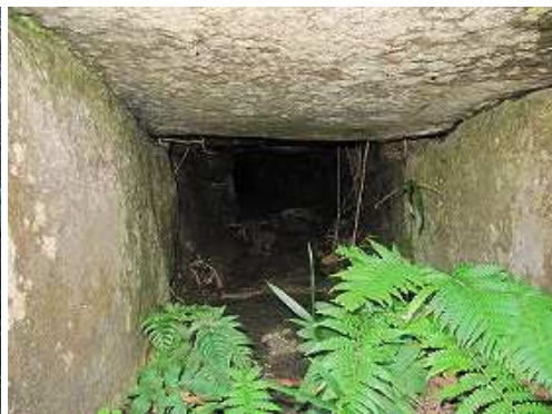
石樋管の内部。
