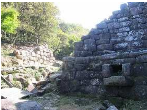
中門西側の石樋管。
