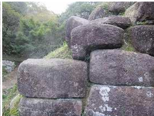
カギ形に加工された石もあり。高度な技術力がうかがえる。
