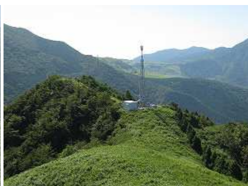
尾根筋の先にTV中継塔を見る。
