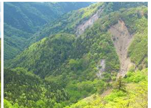
西の露岩帯と崩落地。
