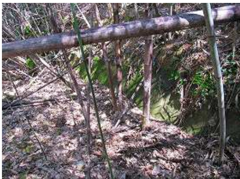
ブロック積みの作業路に降り立つ。
