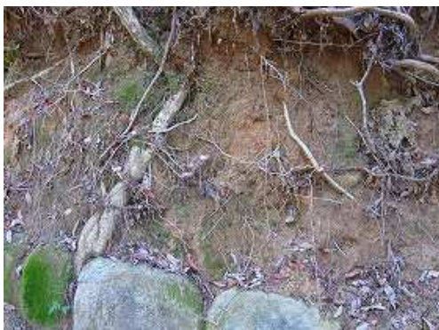
法面 列石上部の斜面に層は見られない。
