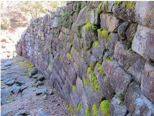
曲線状に構築している。
