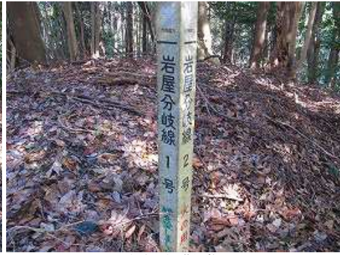
分岐の鉄塔標柱。
