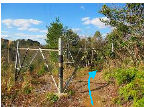
古い鉄塔の下を抜ける。
