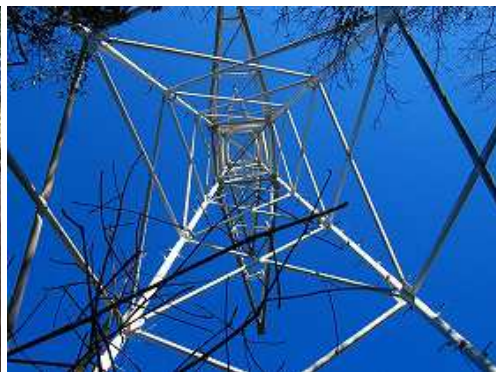
電線が撤去された15鉄塔の真下を通過する。
