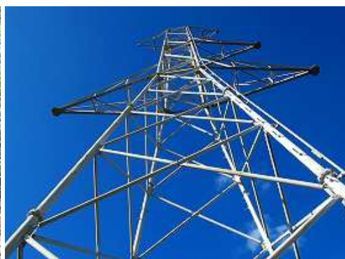
電線が撤去された16鉄塔の傍を通過する。
