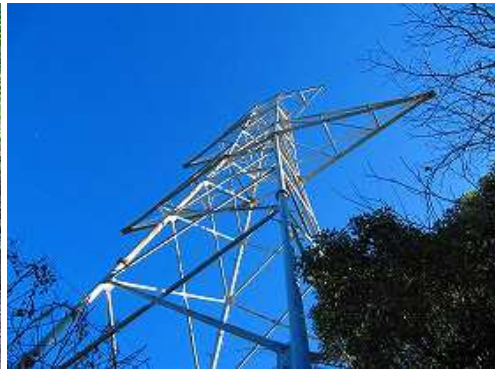
電線が撤去された13鉄塔の傍を通過する。
