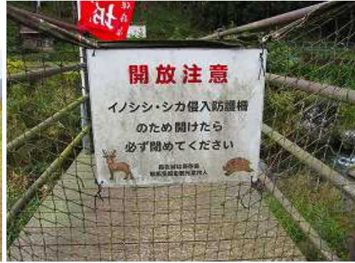
津民川に掛かる長岩橋の入口には、侵入防止のネットが掛けられている。
