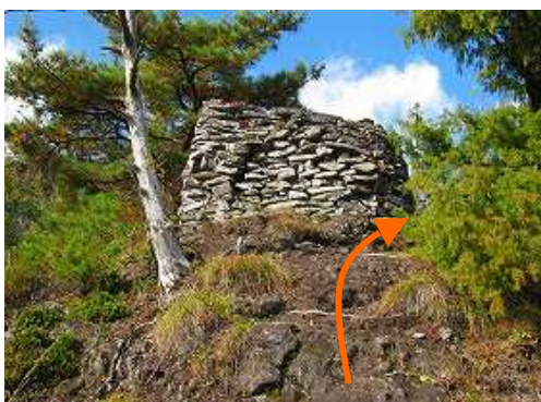
尾根筋から見る石積櫓。
