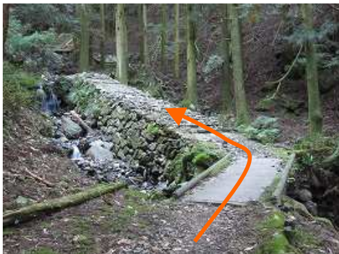
橋を渡り、石積み堤を緩やかに上って行く。
