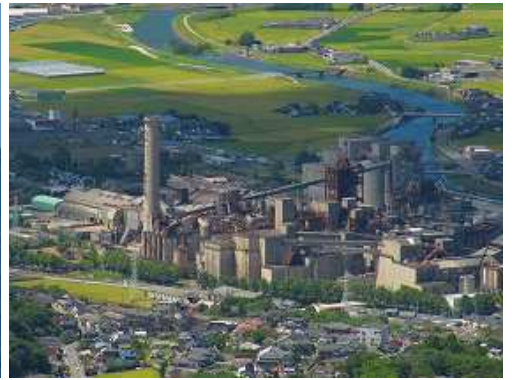
日本セメント香春工場を望遠で撮る。
