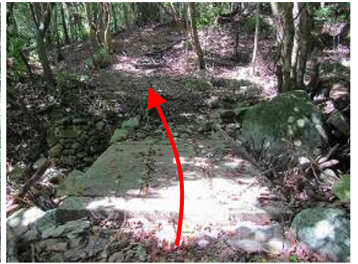
コンクリート橋を渡る。
