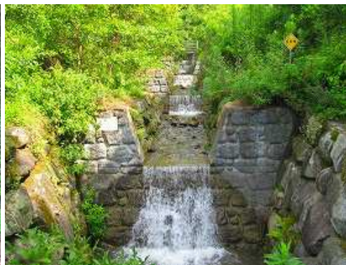
高原川を渡る。上流には多段式の砂防ダムを見る。
