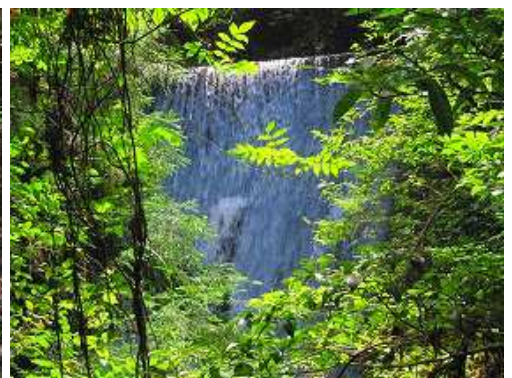
枝越しに堰堤を見る。
