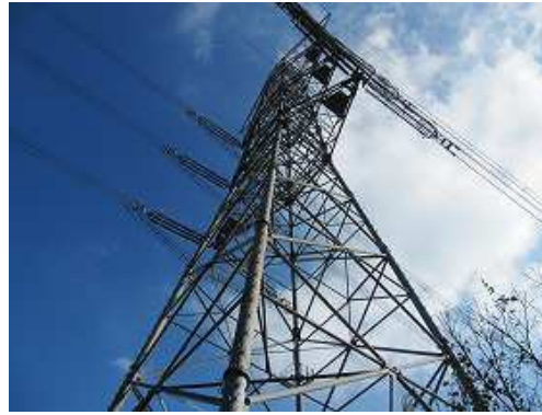
16鉄塔を見上げる。
