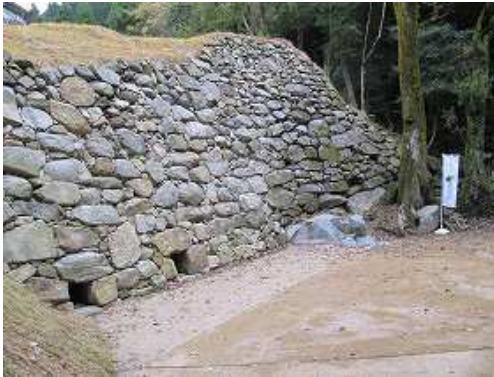
水門石垣保存修理事業は、完了したようだ。
