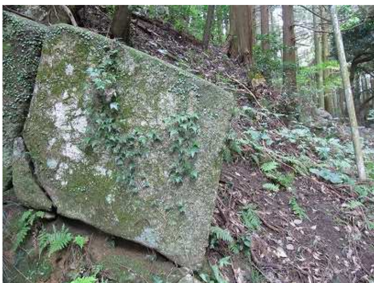
起点の石 幅860mm・高さ750mm。面はほぼ直角に仕上げてあり、基礎栗石はなく、直に置いている。
