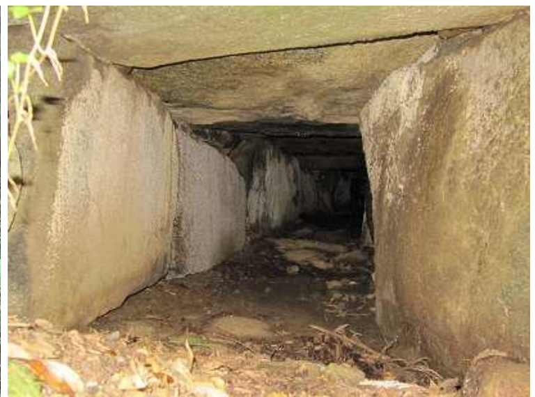
左上の排水樋管の内部。
