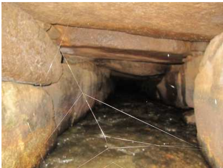
左の排水樋管の内部。
