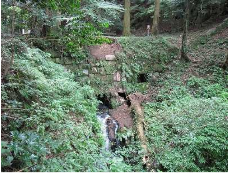
右岸側からの北水門。
