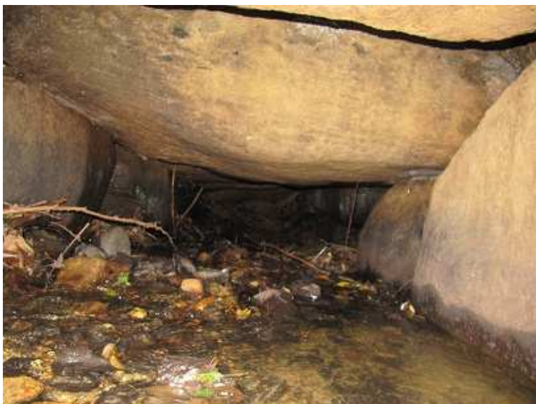
右の排水樋管の内部。
