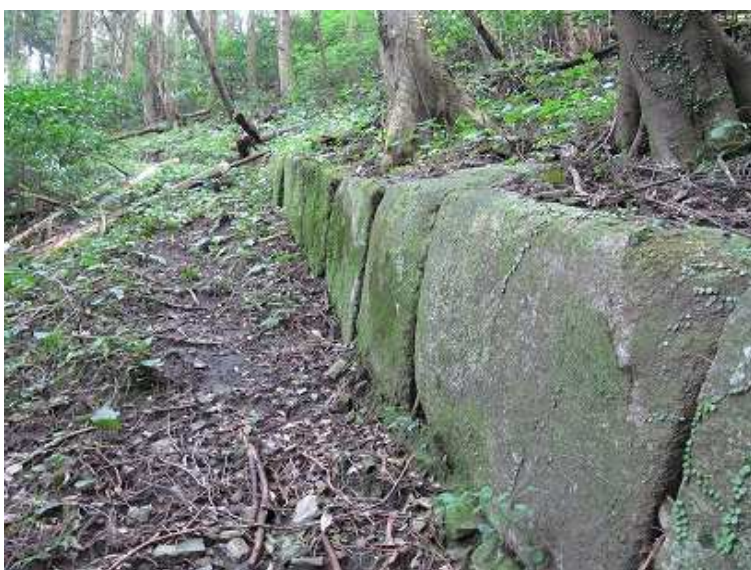
東列石の並び。天端の傾斜は、起点部28°、中間部23°、最上部20°、全面高は750/500/土中へであった。
