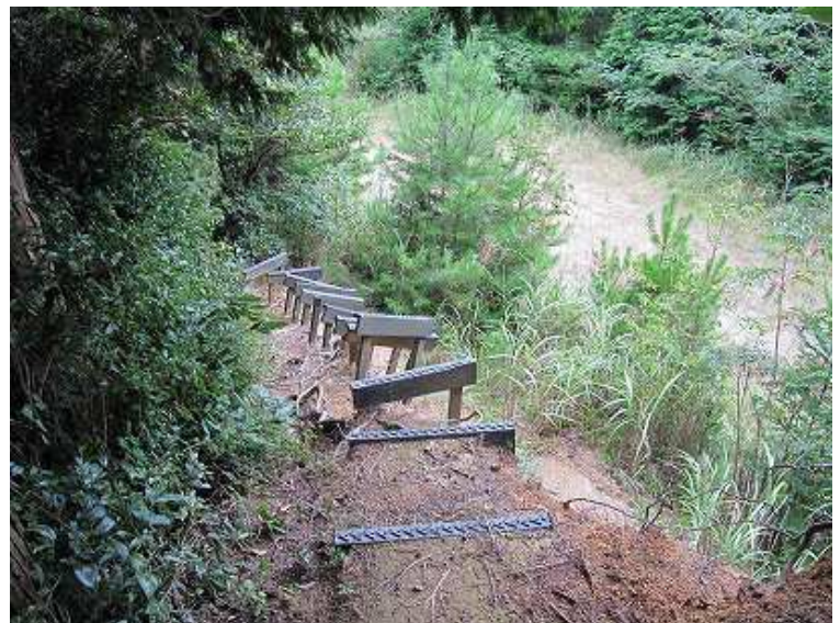
13:54 林道終点到着 プラ階段は土砂が流出して浮き上がっていた
