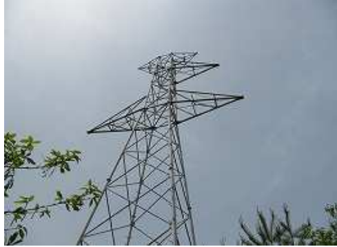
11:14 電線が撤去された送電鉄塔
