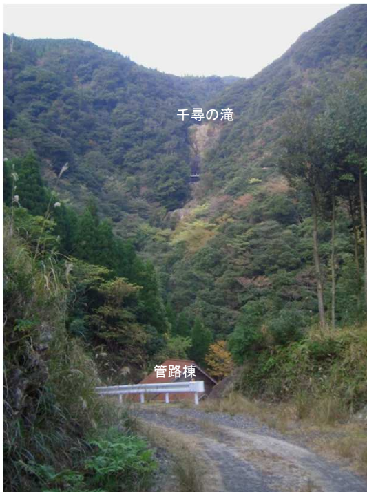
管路棟の先で振り返る
